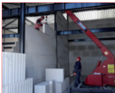
Elementenstelmachine
