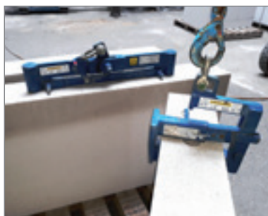
Links: elementenklem Rechts: gebruik passtukkenklem
