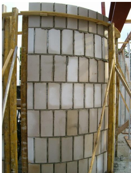
Verticaal vermetselde lijmblokken.
